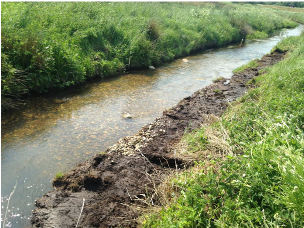
Figur Nr. 16b. Eksempel på nyetablerede gydebanker fra andet gennemført restaureringsprojekt– Fotoet viser strækning med grus-udlægningen – set nedstrøms. Bemærk profiludvidelsen – th. for bækken
