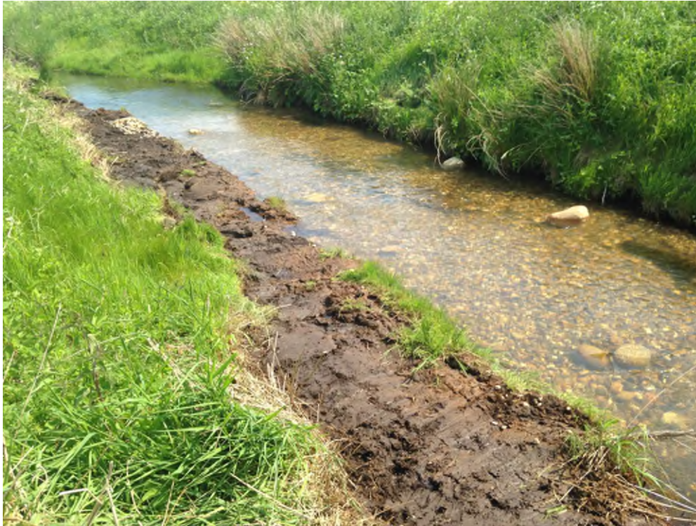
Figur Nr. 16a. Eksempel på nyetablerede gydebanker fra andet gennemført restaureringsprojekt– Fotoet viser strækning med grus-udlægningen – set opstrøms. Bemærk profiludvidelsen – tv. for bækken
